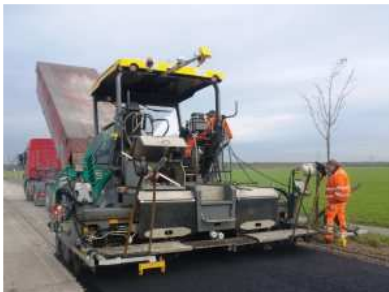
Bild 3 Asphalteinbau mit MOBA Pave-IR
